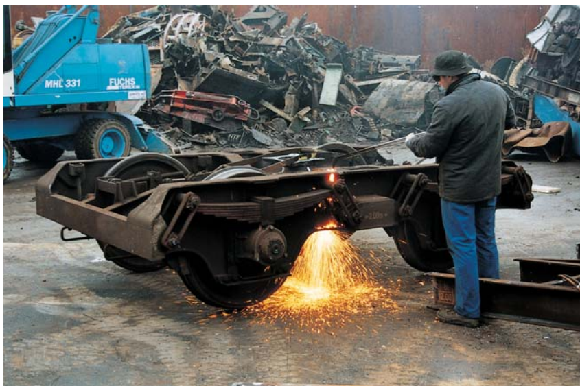
Rekupieren ist Handarbeit: Mitarbeiter beim Schweißen an einem Fabrgestell.
